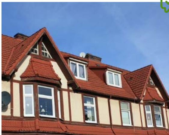
Abb. 103 Schleppdachgauben fügen sich gut in die Dachfläche ein
